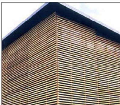
Plademontage udført på fabrik
