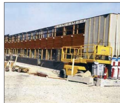
Plademontage udført på byggeplads
