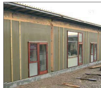
Plademontage udført på fabrik
