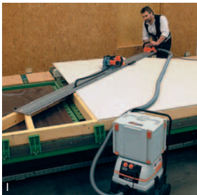
- eller med elektrisk rundsaw
