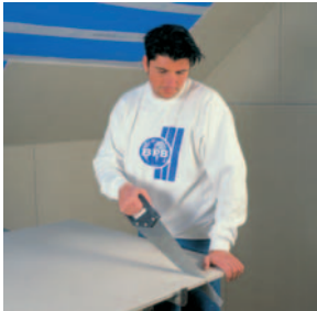
Mindre tilskæringer kan let foretages med alm. håndværktøj
